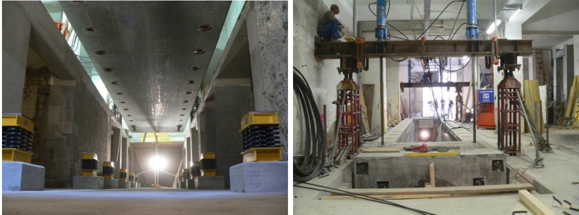
Abbildung 2: Untersicht des Prüfrahmens und Feder Elemente als Auflager für eine schwingungsisolierende Lagerung (rechts); Prüfrahmen während des Absenkens (links).
