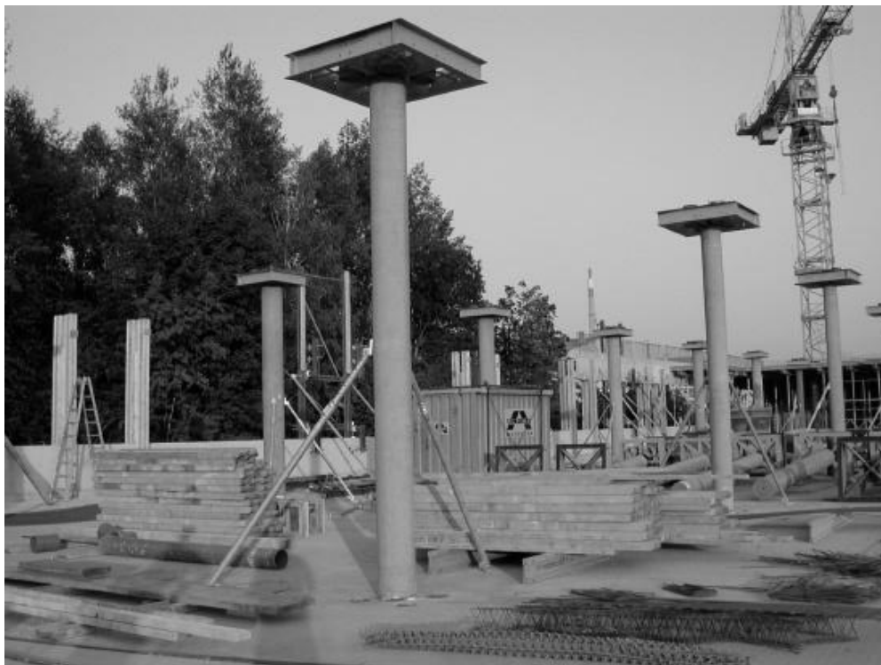
Abbildung 13: Einsatz von hochbewehrten Schleuderbetonstützen beim Bauvorhaben UKH-Linz.
