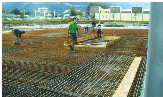
Bild 1. Vorgespannte Decke in Österreich mit großem Anteil an schlaffer Bewehrung
