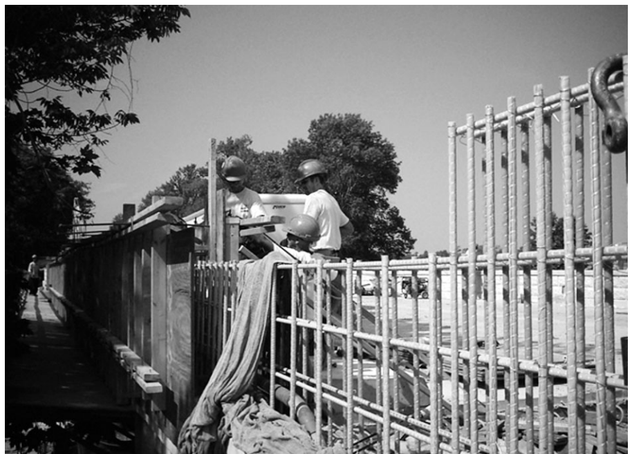
Bild 2. Floodway Bridge, Einbau der Glasfaserbewehrung (Photo: Fortius)
